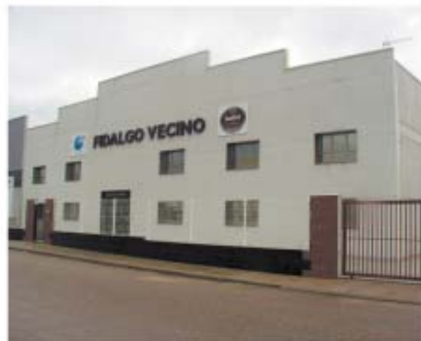
CENTRO DE DISTRIBUCION
